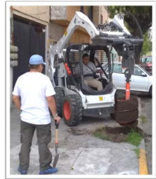
Trabajos de ahoyado para replantación.
