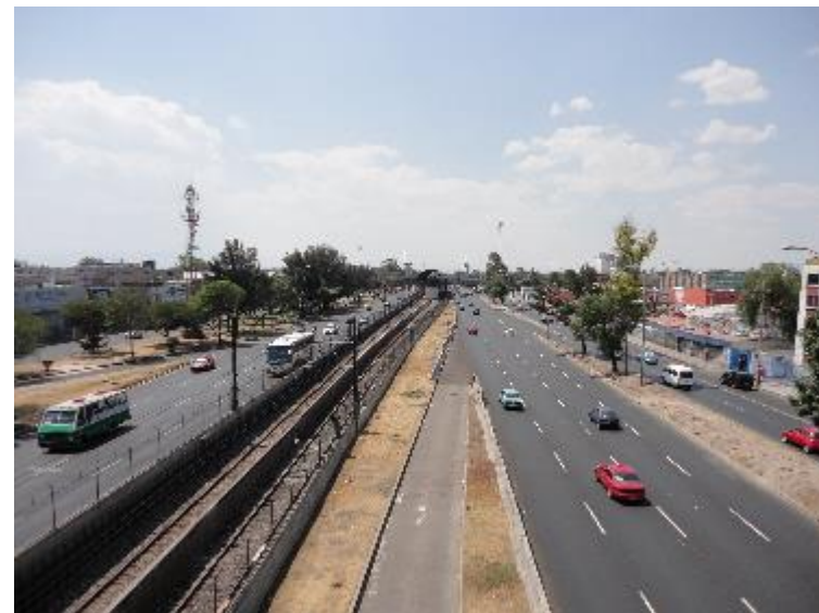
Calzada Ignacio Zaragoza
